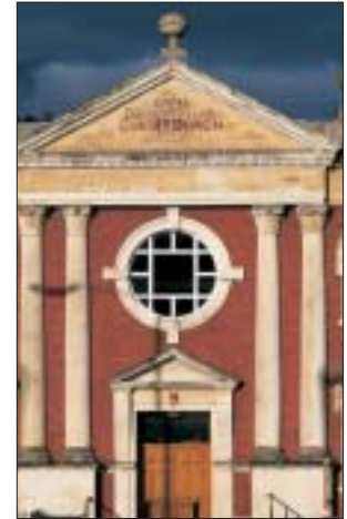
Manyllder y ffasâd. Meddygfa, Pontypridd (Eglwys Bach).
