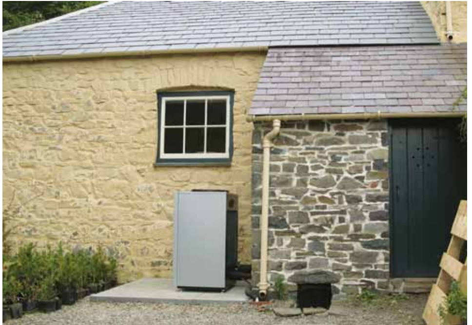
Mae'r pwmp gwres o'r ddaear hwn wedi'i gysylltu â system wresogi o dan y llawr ac mae wedi'i osod yn y lleoliad lleiaf amlwg posibl yn yr ardal wasanaeth y tu cefn i floc stablau a addaswyd.
