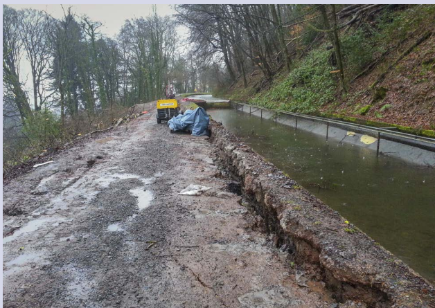
Y tir yn llithro i ffwrdd oddi wrth leinin concriid y gamlas ger Pont Tod.
